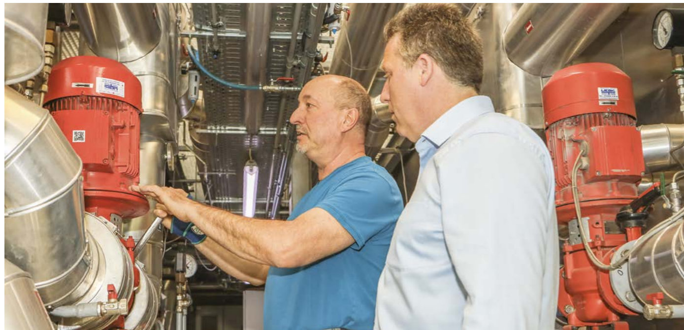
Durch die Kühlung der Rauchgase entsteht Abwärme. Diese wird aus dem Kremationsprozess ausgekoppelt und zur Eigennutzung überführt.
